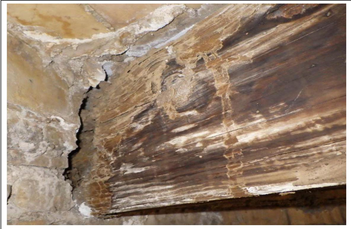
Imagen 8. Degradaciones por hongos y termita en el empotramiento de una viga de carga.
