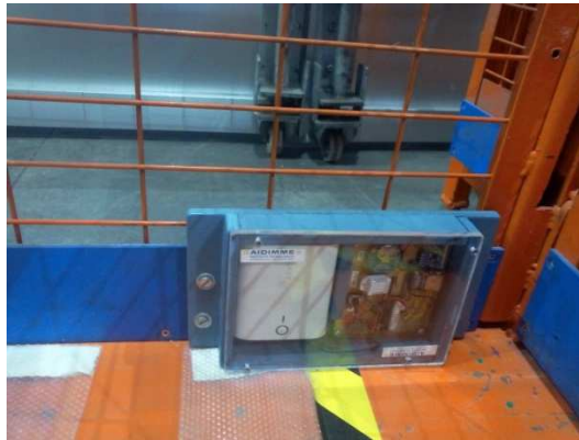
Figura 37. Instalación dispositivo en unidad de carga (iv).
