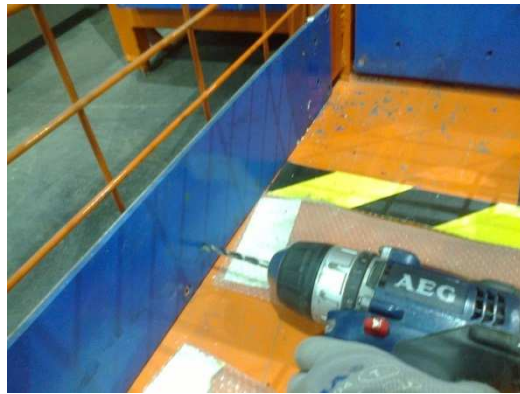
Figura 35. Instalación dispositivo en unidad de carga (ii).
