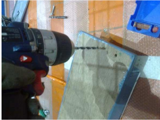
Figura 34. Instalación dispositivo en unidad de carga (i).
