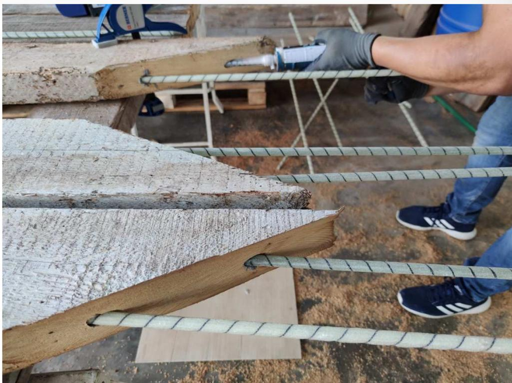
**Imagen 11.** Vigas en proceso de ser consolidadas con resina y varillas de fibra de vidrio. Estas vigas presentaban degradación en la parte superior y se sanearon mediante corte en diagonal.
