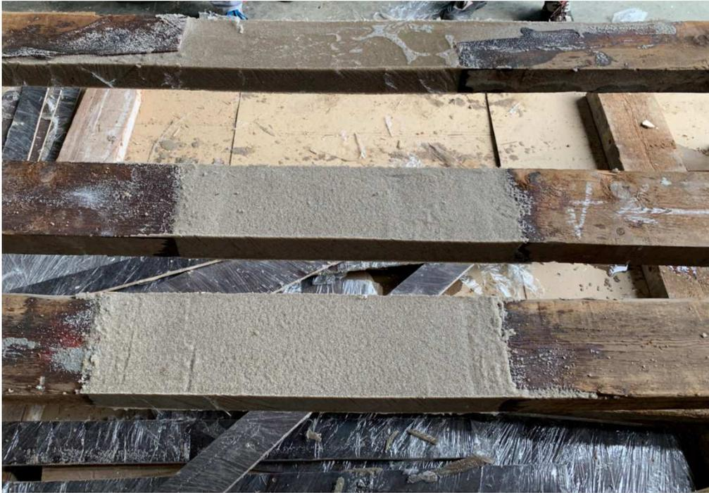
*Imagen 13. Vigas consolidadas en el centro, por presencia de degradación o de rotura.*
