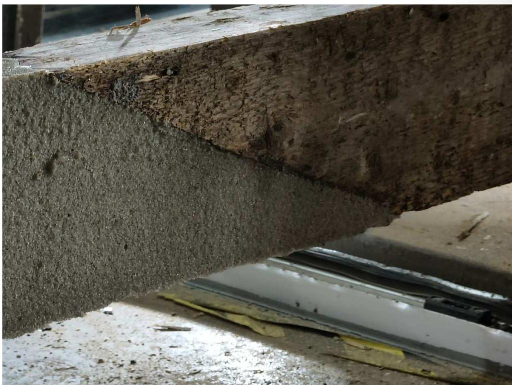
**Imagen 12.** Detalle de una de las vigas anteriores después de ser consolidada.
