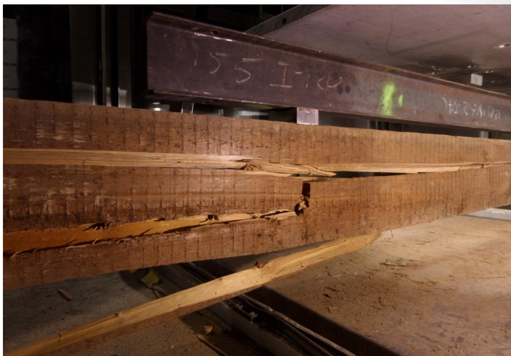
Imagen 3. Rotura de una viga de abeto antiguo durante el ensayo de resistencia a flexión según la norma UNE-EN 408. Es necesario realizar ensayos destructivos para validar y perfeccionar los resultados de los ensayos no destructivos.
