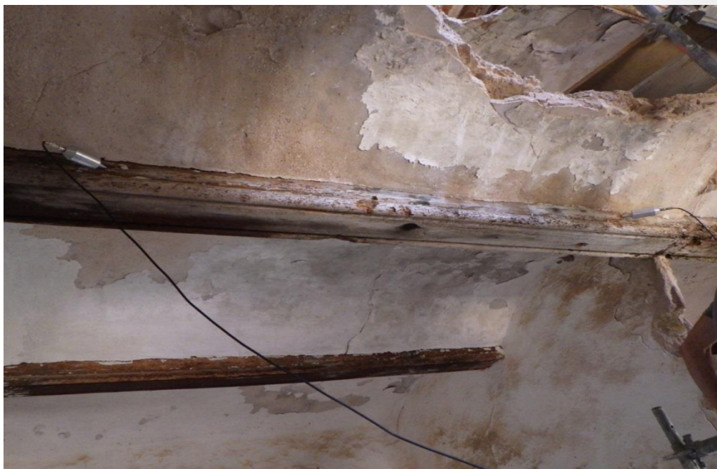
Imagen 2. Ensayo no destructivo de emisión-recepción de ultrasonidos en una viga de una alquería del patrimonio histórico valenciano. Esta técnica, junto a otras, se ha investigado y se incluye en la metodología desarrollada en MEND-ME.
