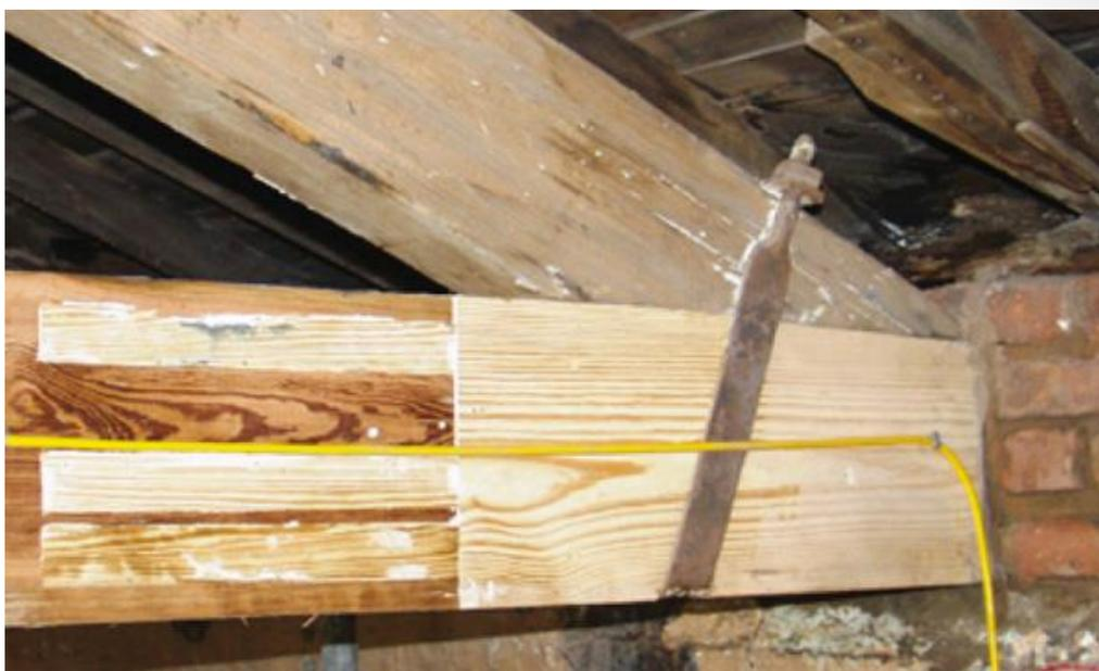
*Imagen 2. Ejemplo de reparación de cabeza de viga mediante injerto de madera. Fuente: [www.timber.org.uk](http://www.timber.org.uk)*
