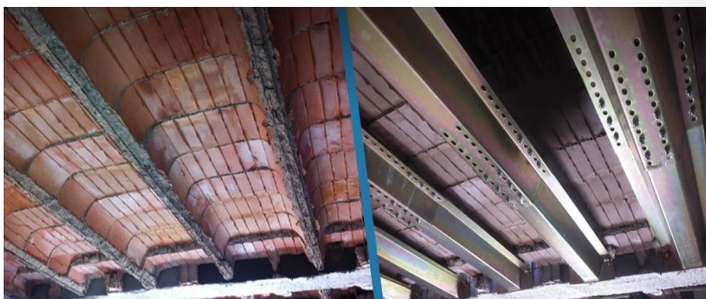
*Imagen 3. Ejemplo de refuerzo de viguetas de madera con viguetas metálicas. Fuente: [www.mecanoviga.com](http://www.mecanoviga.com)*
