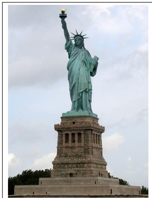
Imagen 11. El pedestal de la estatua de la Libertad, que alberga el museo y habitaciones de servicio, sufrió en la década de 1990 una grave infestación de termitas en la madera. Debido al temprano tratamiento, solamente resultaron afectadas las vitrinas de madera del museo, y no los objetos valiosos y documentos históricos que contenían. En los casos en los que los monumentos están ubicados cerca de puertos, no es posible inyectar en el suelo grandes cantidades de insecticida líquido, porque se contaminaría el hábitat marino. Fuente de la imagen: Wikipedia
