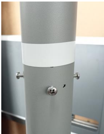
Ilustración 34: Marcado de altura para posicionar el soporte
