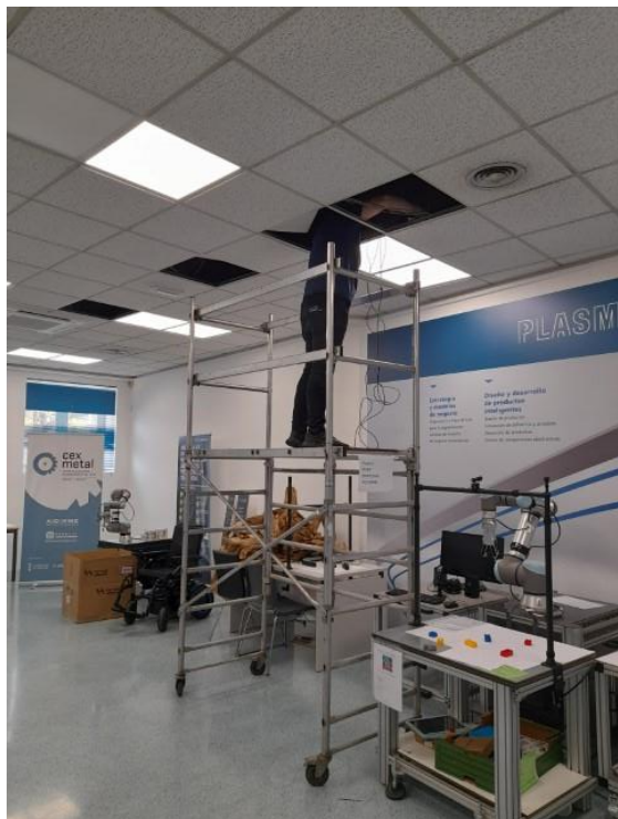
Ilustración 1. Instalación de los receptores inalámbricos en el techo desmontable
