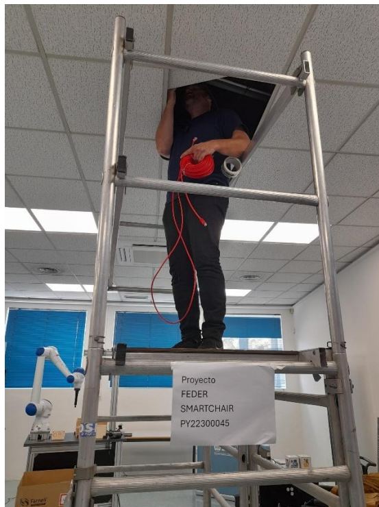
Ilustración 2. Montaje de los cables de conexión en el techo desmontable
