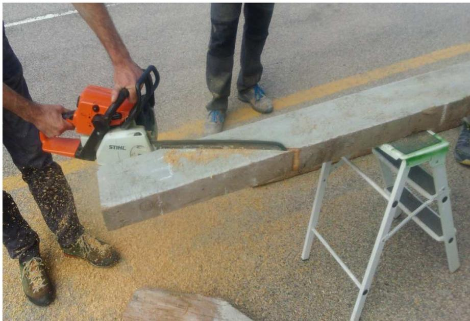
Saneamiento en diagonal de la parte de empotramiento izquierdo de una viga.
