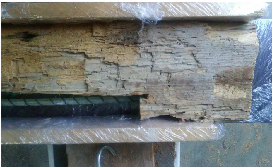
Parte saneada de una viga, en la que ya se ha colocado una varilla de fibra de vidrio pretensada y que se encuentra preparada para encofrarse con una mezcla de resina y árido.
