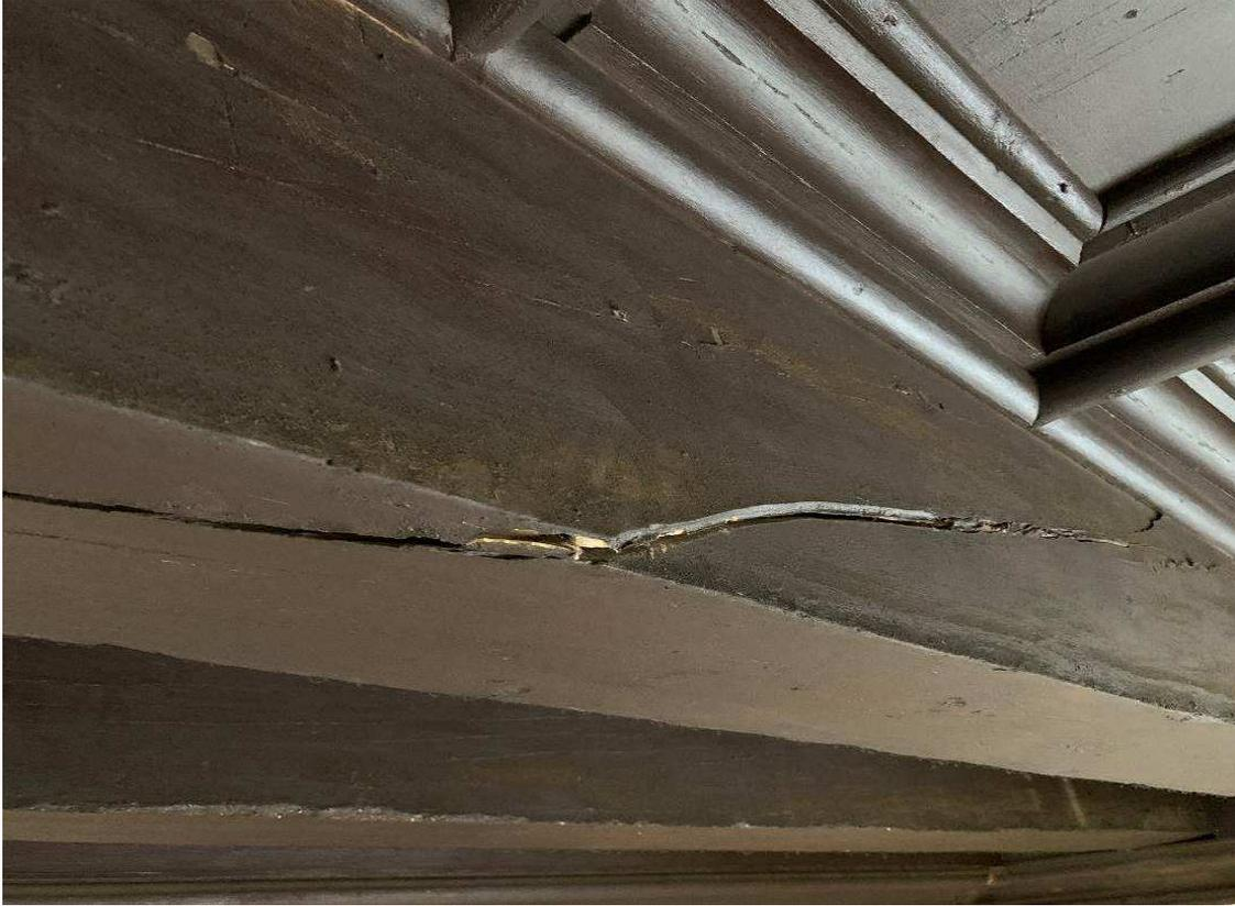
Rotura por fendas de vigueta de forjado.
