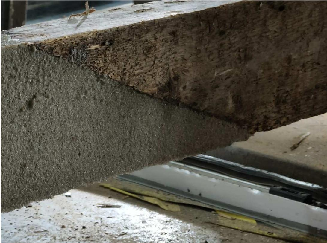
Detalle de una de las vigas anteriores, saneadas mediante corte en diagonal, después de ser consolidada.
