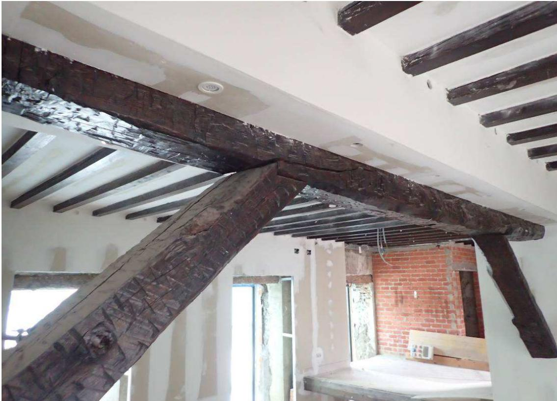
Rotura por fendas de viga en forjado.
