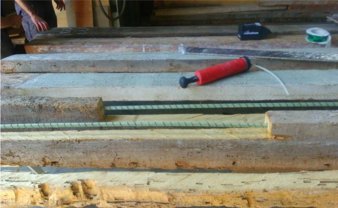
Vigas en proceso de ser consolidadas con resina y varillas de fibra de vidrio. Estas vigas presentaban degradación o rotura en la parte central, que fue saneada.
