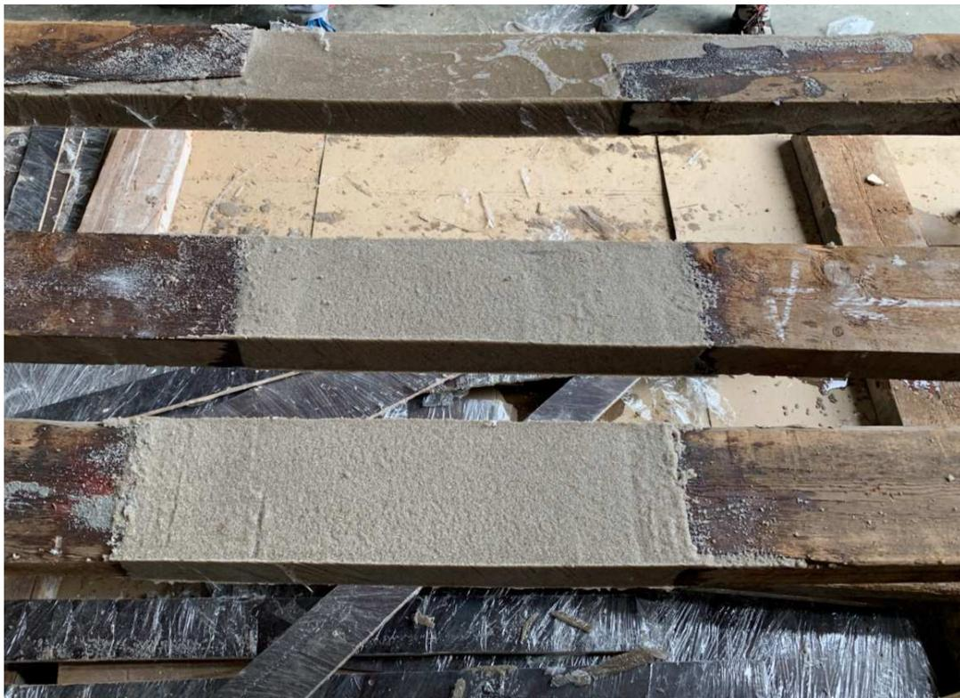
Vigas consolidadas en el centro, por presencia de degradación o de rotura.
