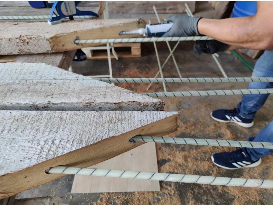
Vigas en proceso de ser consolidadas con resina y varillas de fibra de vidrio. Estas vigas presentaban degradación en la parte superior y se sanearon mediante corte en diagonal.
