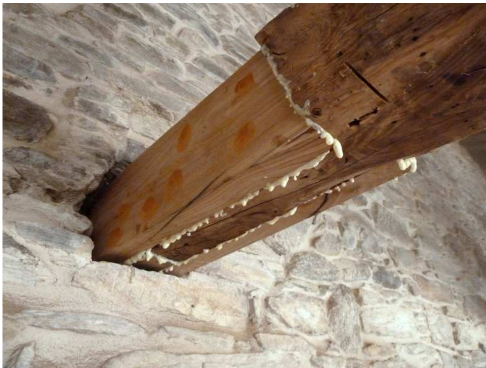
Ejemplo de refuerzo mediante injerto en la cabeza de una viga. Fte. AEstudio Arquitectura y Urbanismo
