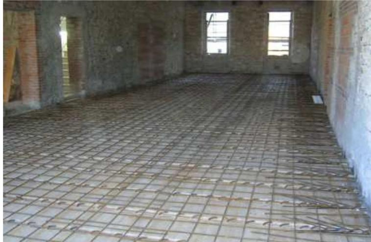
Ejemplo de solución de refuerzo completo (solera de hormigón con malla y conectores) en un forjado de madera.
