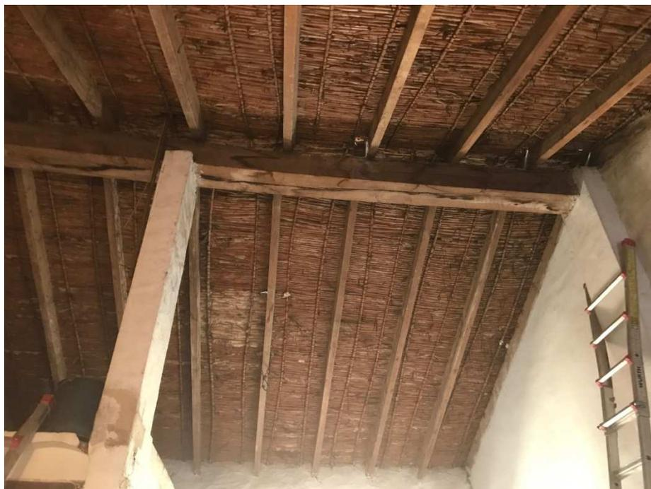
**Estructura de cubierta combinado de vigas de carga de mobila y viguetas de abeto en Alcudia. Fte. AIDIMME**
