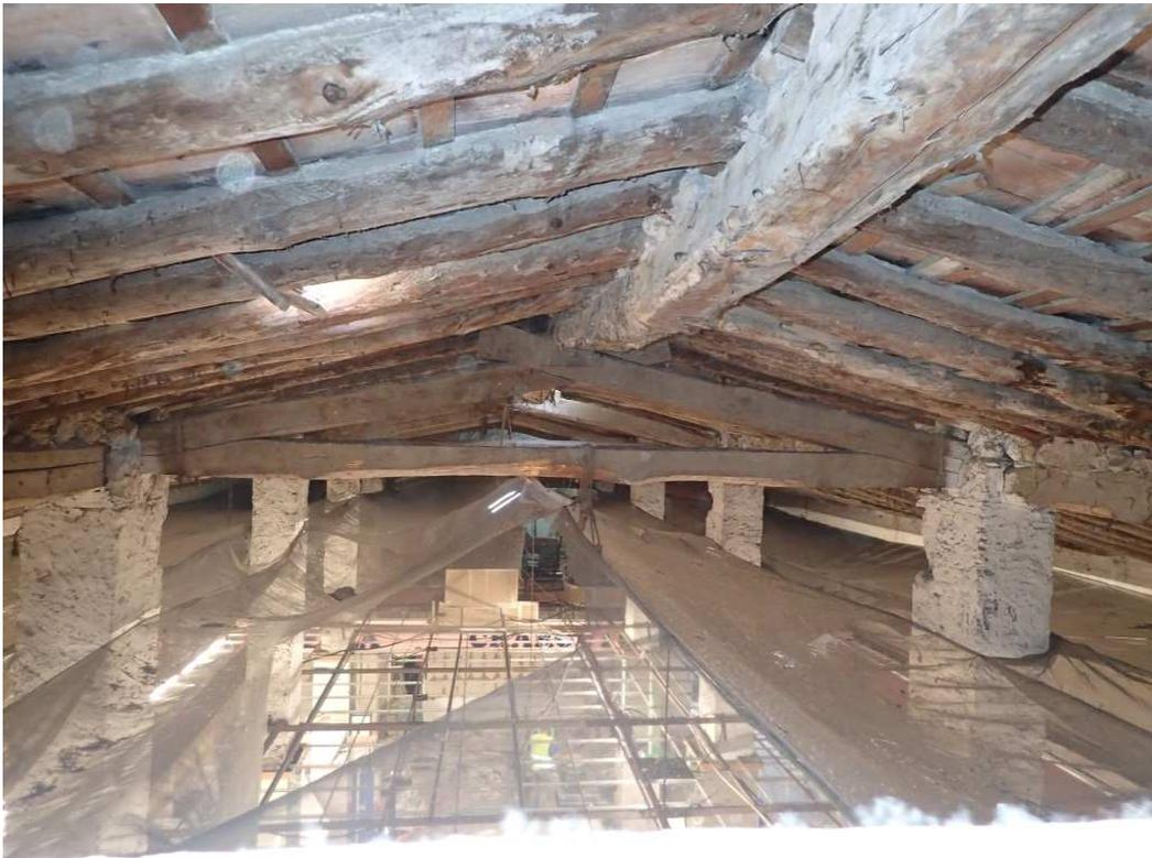
Estructura de cubierta de madera de vigas de carga de chopo y vigas de pinos locales (*Pinus halepensis*). Fte. AIDIMME
