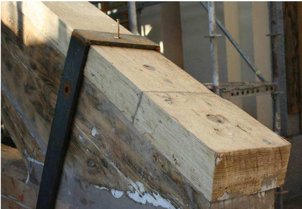
Ejemplo de producto de refuerzo (madera microlaminada) en la parte superior de una cercha deteriorada de madera. Fte. CIS-MADEIRA
