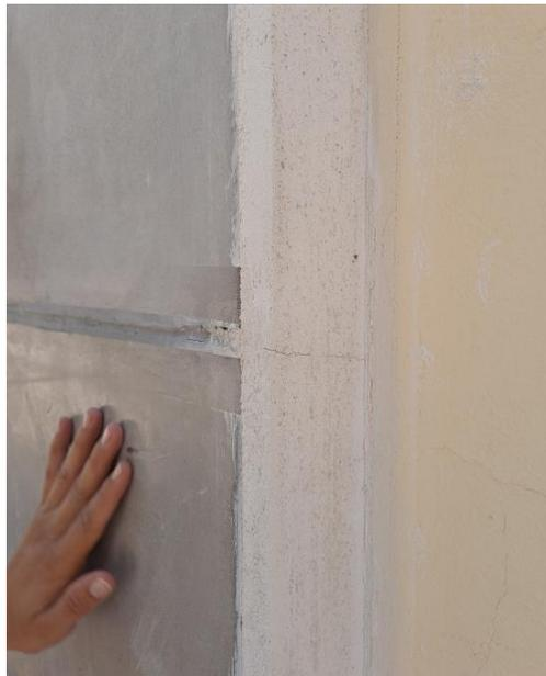
**Figura 9.** Terminado lateral con enlucido de mortero.
