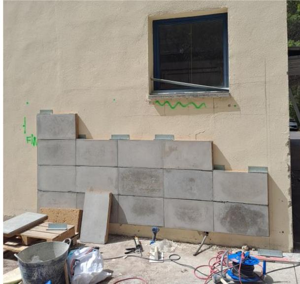
Figura 11. Montaje paneles SATE.
