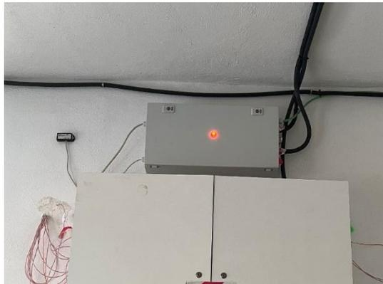
**Figura 24:** Cuadro eléctrico + sensor de temperatura/humedad.
