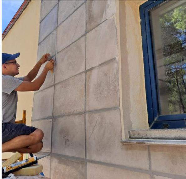
**Figura 8.** Colocación de sellador.
