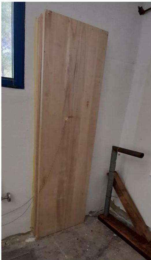
**Figura 10.** Montaje de trasdosado SATI
