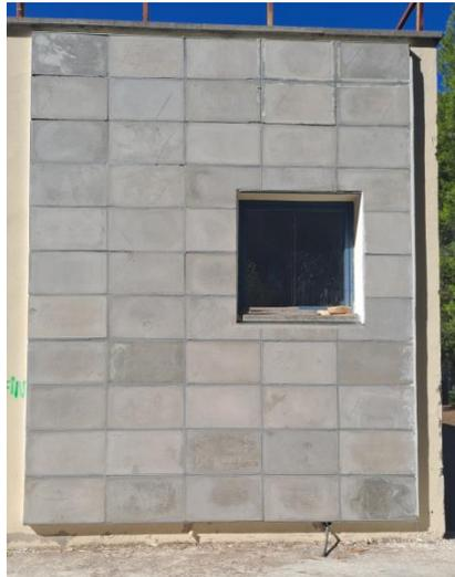
Figura 12. Muro SATE montado.
