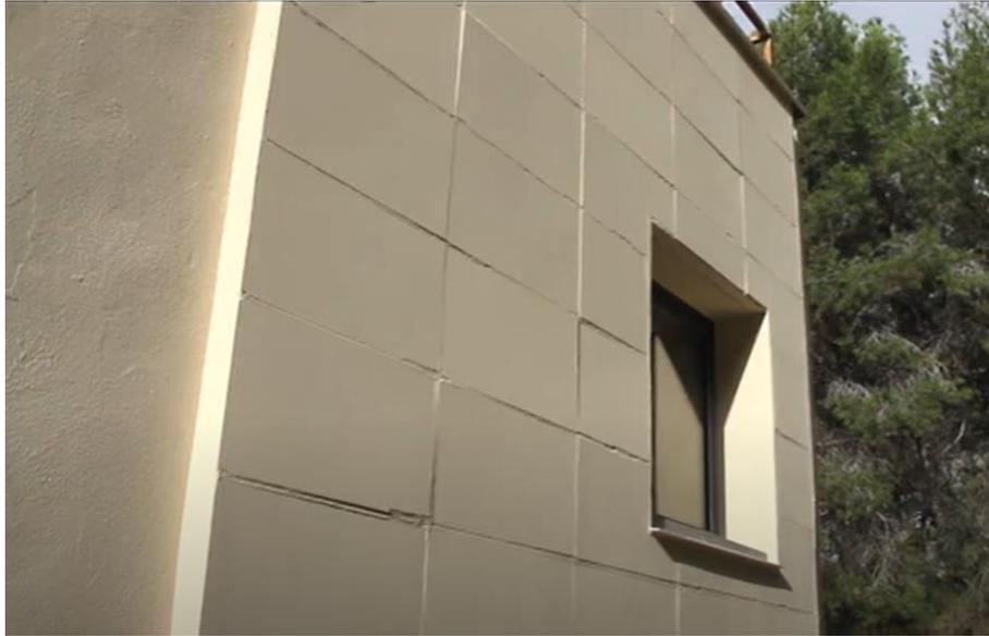
**Figura 28.** Paneles instalados en la fachada Este del edificio piloto.
