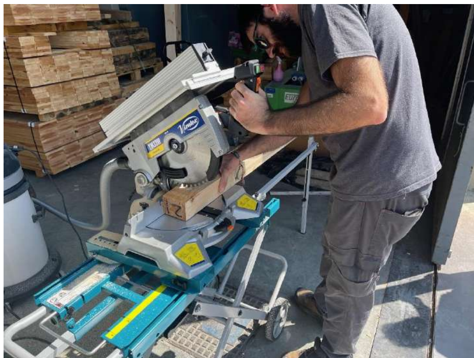
Figura 278. Retesteado de vigas a longitud de 2 metros.
