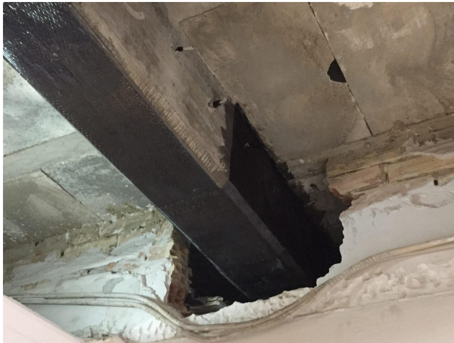
Ejemplo de refuerzo de la cabeza de una viga mediante FRP. Fuente: SOFCAR
