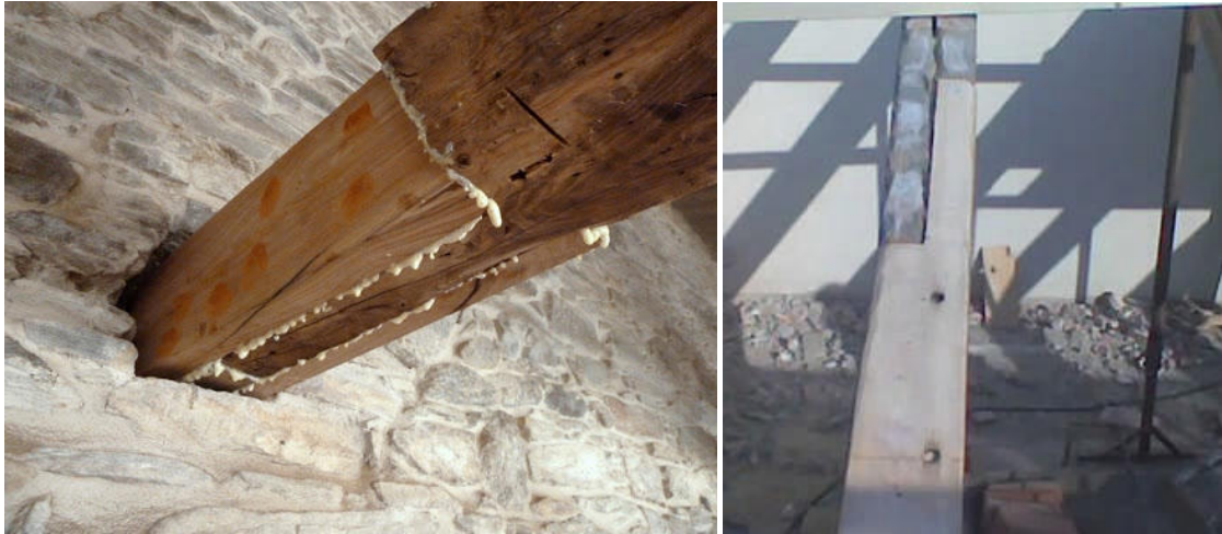
Ejemplos de refuerzos mediante prótesis de madera.
