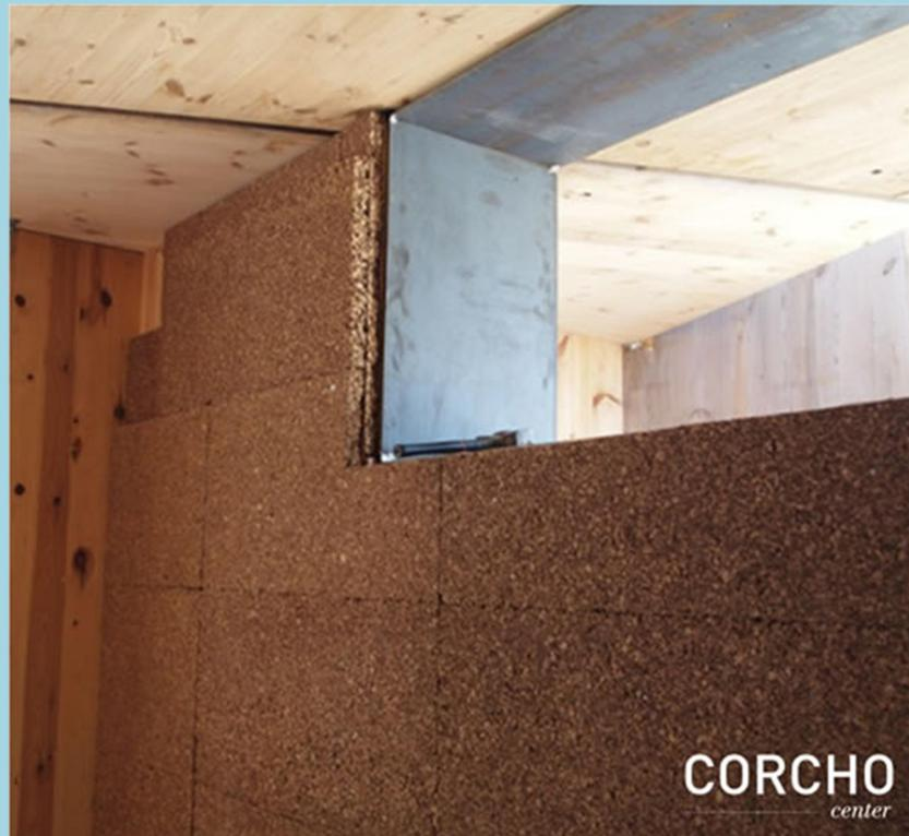
**Aislamiento de una pared mediante tableros de corcho negro expandido.**
