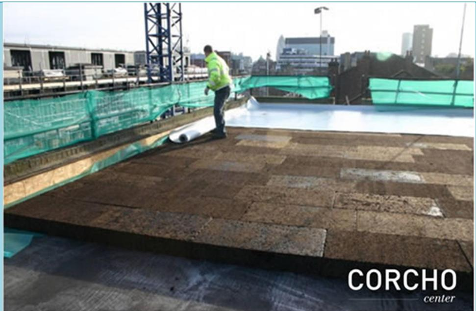
**Aislamiento de una cubierta mediante tableros de corcho negro expandido.**
