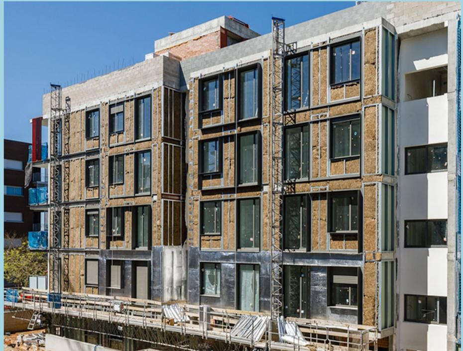
Aislamiento de una fachada mediante lana de roca. Fuente: ULMA ARCHITECTURAL SOLUTIONS
