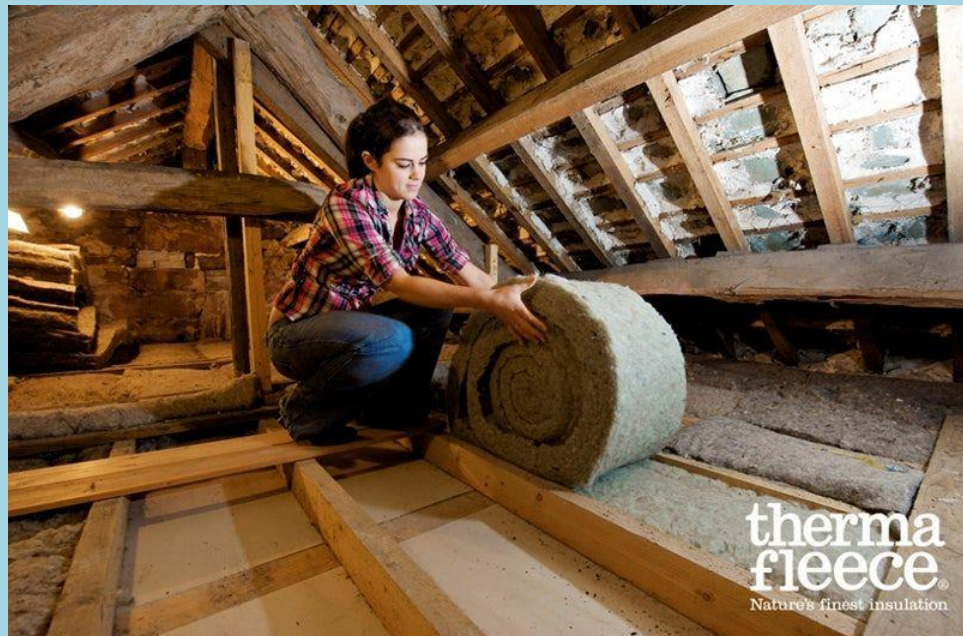
Sistema de aislamiento con lana de oveja donde se aprecian los listones de madera. Fuente:
