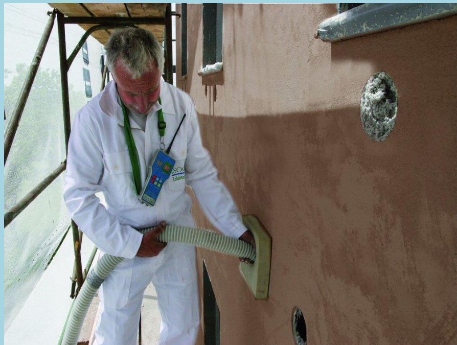
Relleno con la celulosa. Fuente: Isocell
