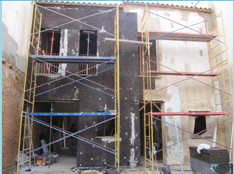
Proceso de montaje del sistema de aislamiento. Fuente: Barnacork
