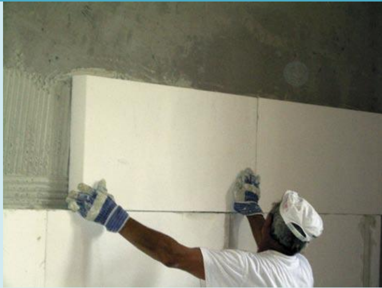
Paneles y montaje del sistema Promatect-MC. Fuente: PROMAT
