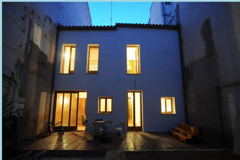
Resultado final con el sistema de aislamiento. Fuente: Barnacork
