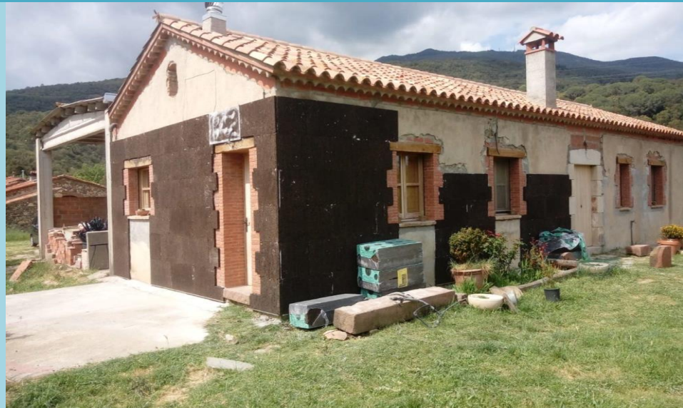
Proceso de montaje del sistema de aislamiento. Fuente: Barnacork
