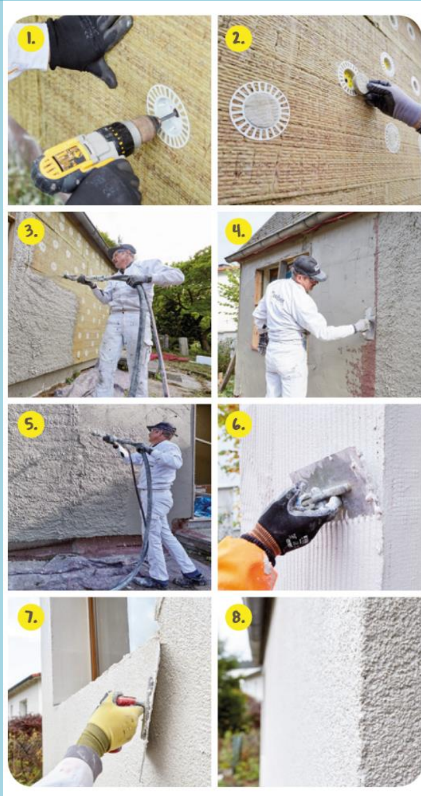
Etapas sucesivas de instalación del sistema Webertherm Circle. Fuente: Saint-Gobain Weber
