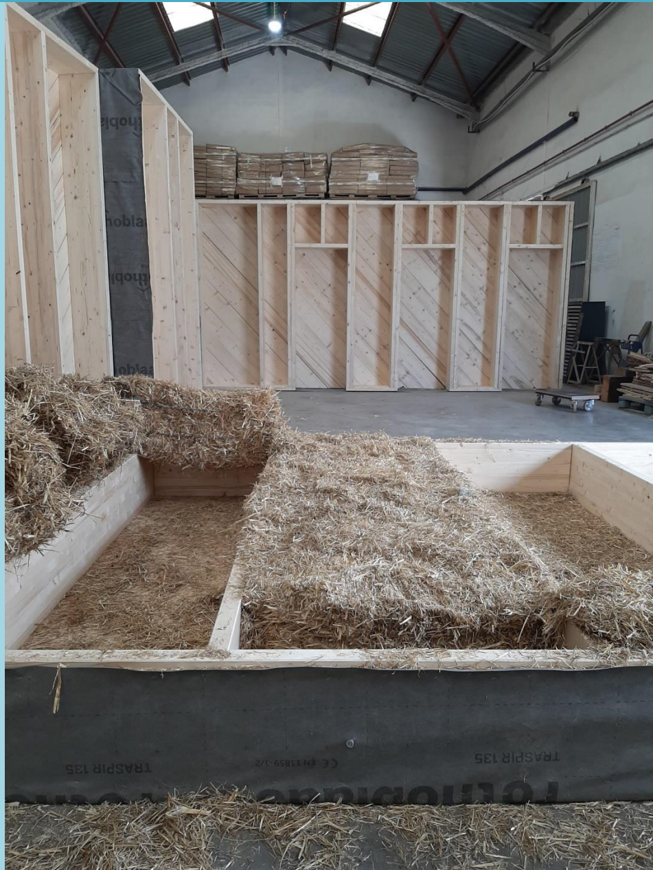
Preparación de la construcción del centro de día de Meliana. Fuente: Grupo Serpa.
