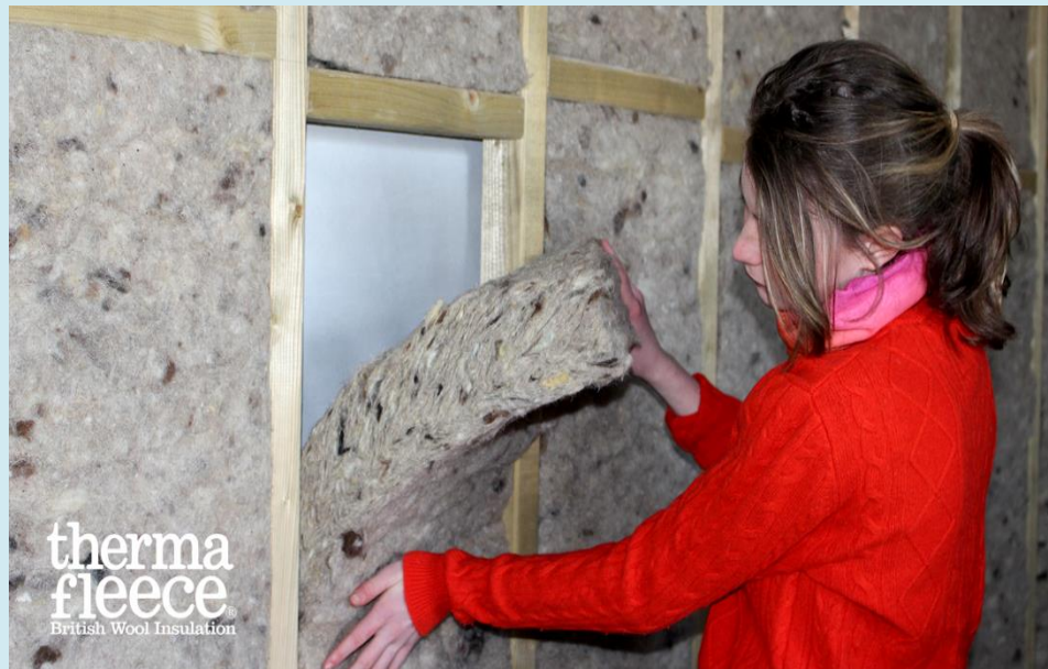
Colocación de un trozo del rollo de lana. Fuente: Therma fleece
