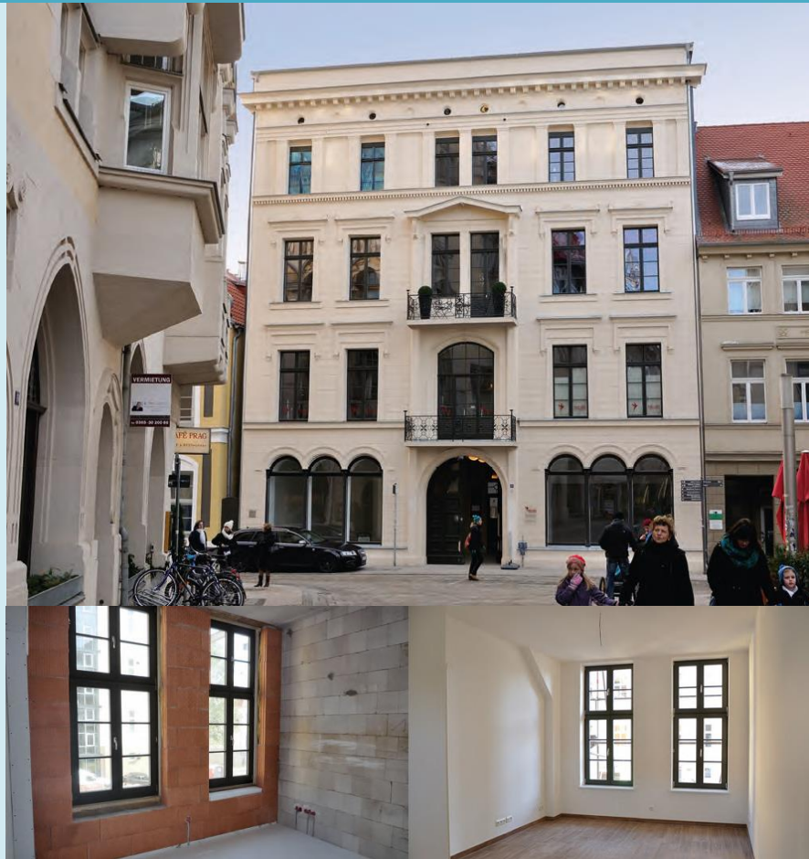
Imágenes del sistema de aislamiento Poroton WDF aplicado por el interior en un edificio residencial/comercial de Schwerin (Alemania). Fuente: Wienerberger
