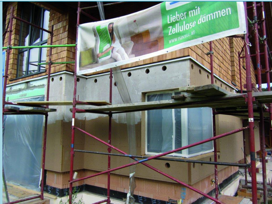
Montaje de los montantes con el hueco para su relleno. Fuente: Isocell
