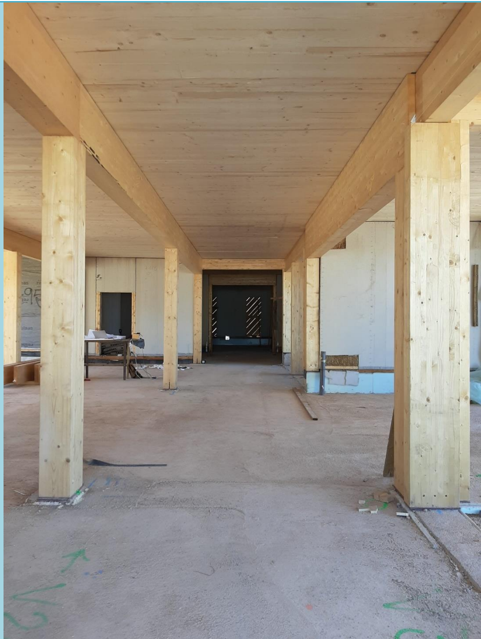
Acabado interior del centro de día de Meliana. Fuente: Grupo Serpa
