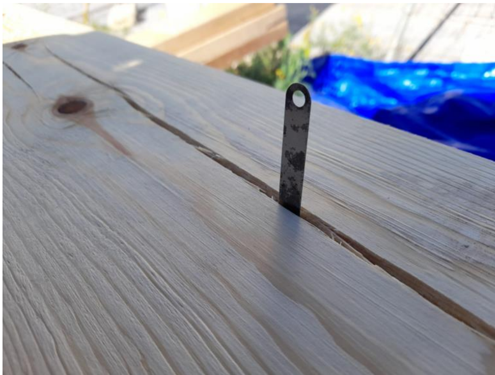
Figura 6. Medición de fenda
