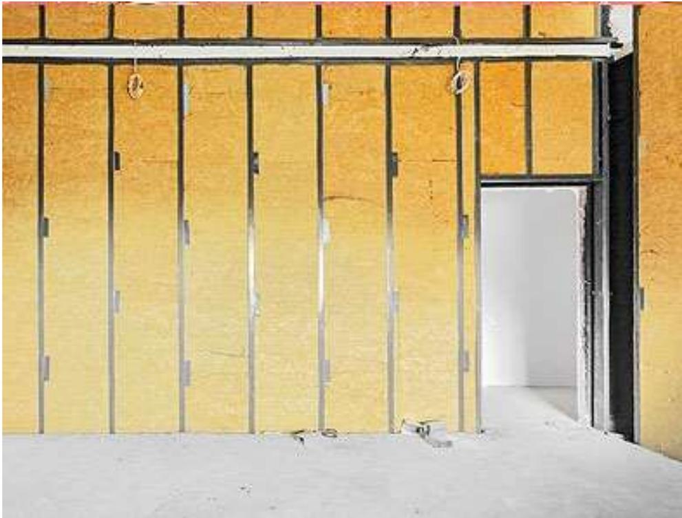
**Imagen 8. Detalle de un tabique de visión interior para oficinas hecho con lana de roca, antes de ser revestido. Los paneles de INNOCOND pueden usarse en lugar de la lana de roca, que tiene un gran impacto medioambiental, necesita mucha energía para su fabricación y tiene un reciclado costoso. Además, los paneles de INNOCOND tienen mayor resistencia mecánica que la lana de roca y pueden quedar vistos. Fuente de la imagen: Cantitect**
