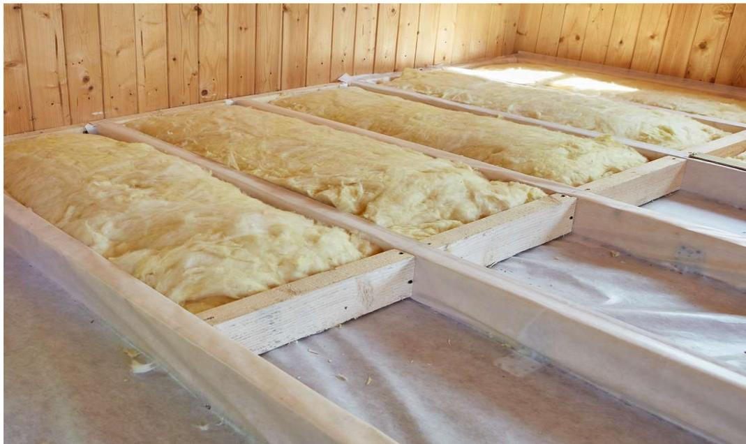
**Imagen 23.** Suelo entarimado parcialmente relleno de lana de vidrio como aislante. Los paneles de INNOCOND pueden usarse en lugar de la lana de vidrio. Fuente de la imagen: Mass Foam System
