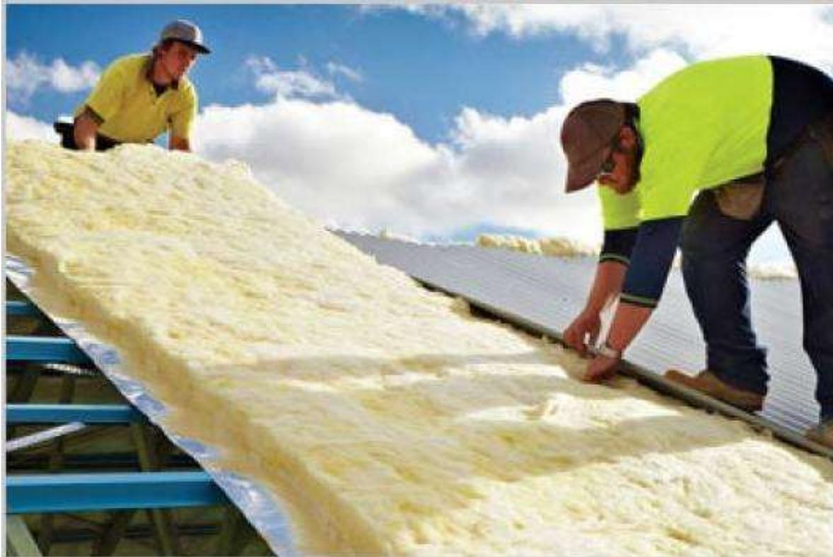
**Imagen 14. Detalle de la colocación de material aislante (lana de vidrio) en una cubierta inclinada. Los paneles de INNOCOND pueden usarse en lugar de la lana de vidrio, que tiene un gran impacto medioambiental, necesita mucha energía para su fabricación, tiene un reciclado costoso y a menudo se usan para fabricarla ligantes que contienen formaldehído. Fuente de la imagen: Civiconcepts**
