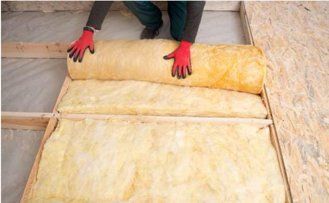
**Imagen 22.** Detalle de la colocación de material aislante (lana de vidrio) en un suelo entarimado. Los paneles de INNOCOND pueden usarse en lugar de la lana de vidrio, que tiene un gran impacto medioambiental, necesita mucha energía para su fabricación, tiene un reciclado costoso y a menudo se usan para fabricarla ligantes que contienen formaldehído. Fuente de la imagen: Civiconcepts
