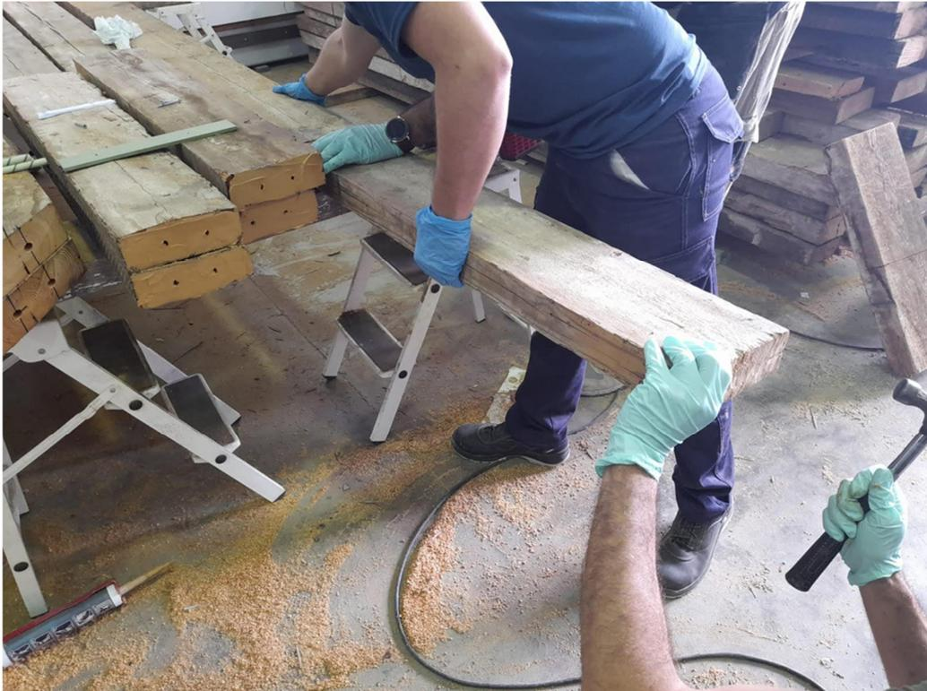
Figura 31. Unión prótesis-viga
