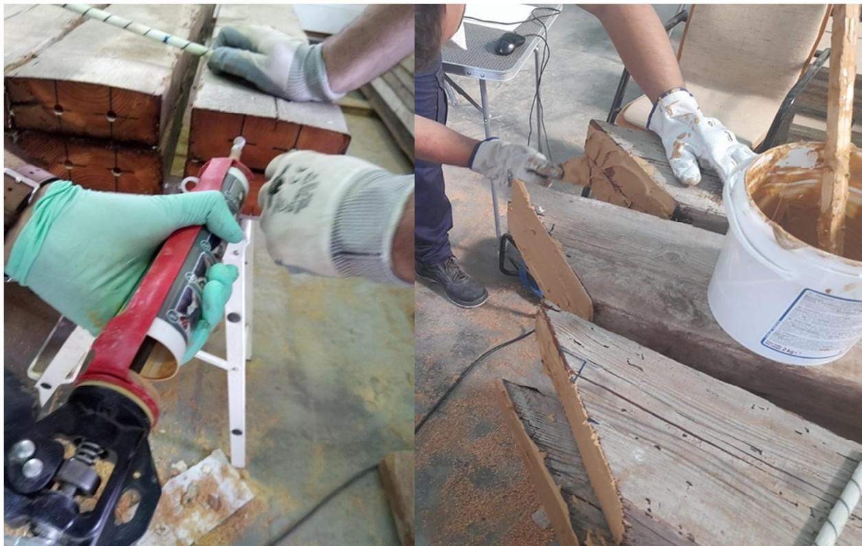
Figura 28. Impregnado con el adherente
