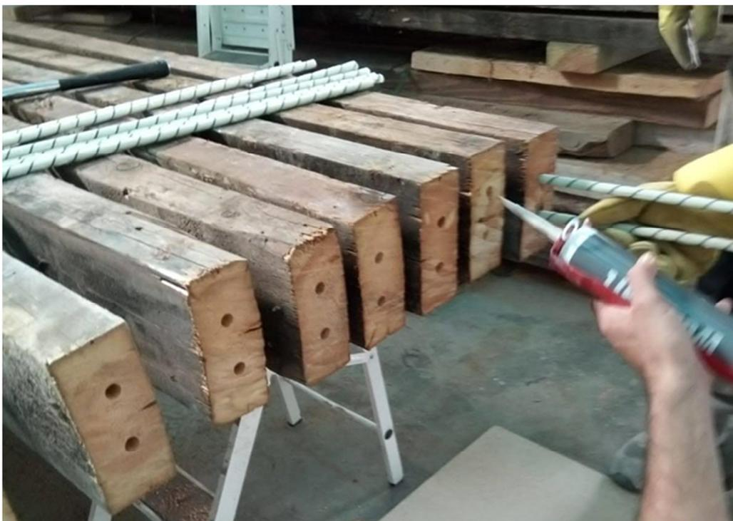
Figura 5. Introducción del adherente con la pistola
