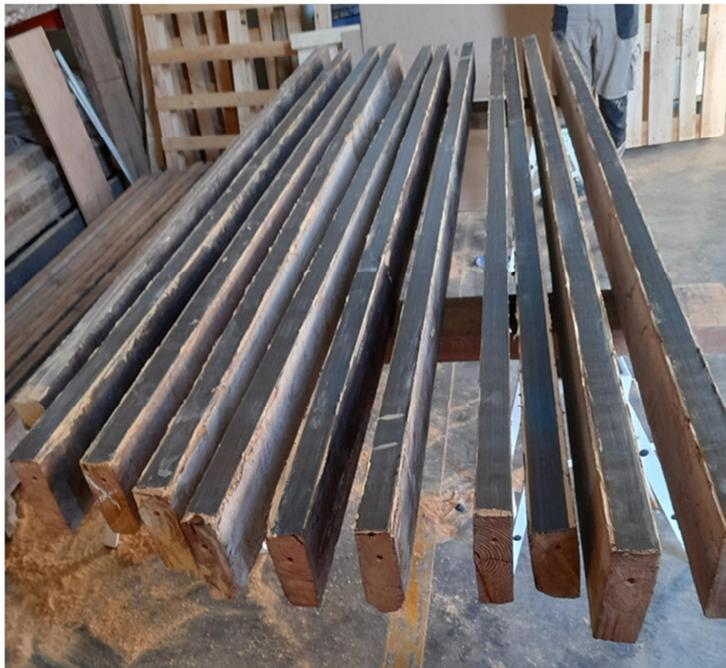
Figura 20. Resultado final con FRP solapado para todas las vigas
