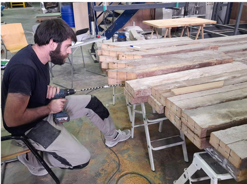
Figura 24. Taladrado para introducción de las varillas
