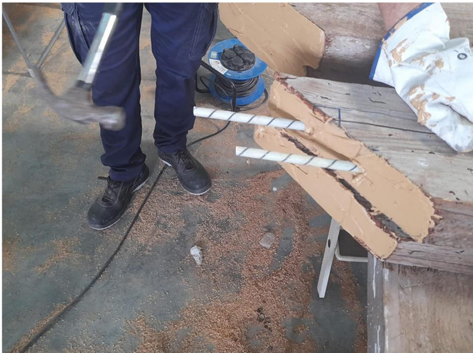
Figura 30. Introducción de las varillas
