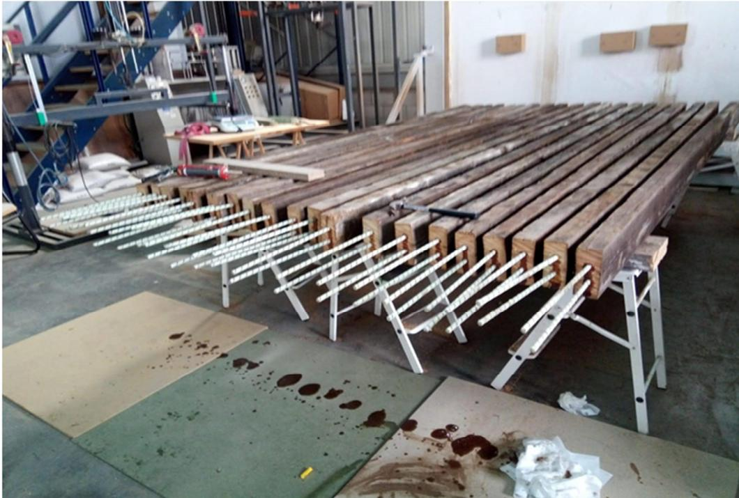
Figura 6. Partes sanas de las vigas con varillas de fibra de vidrio adheridas
