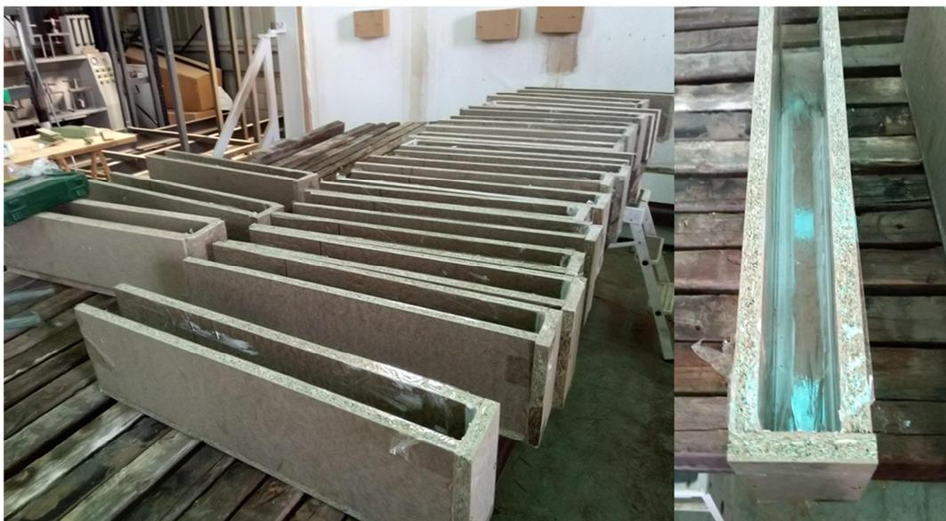
Figura 7. Encofrado premontado, plastificado y sellado.
