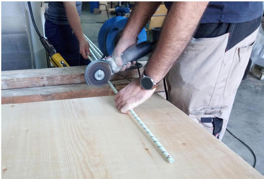
Figura 26. Corte de la varilla de fibra de vidrio
