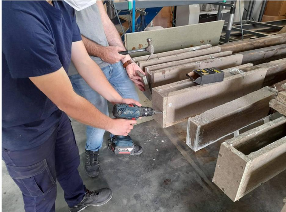
Figura 10. Retirada del encofrado
