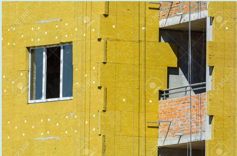
Aislamiento de una fachada mediante lana de vidrio. Fuente: 123rf.com
