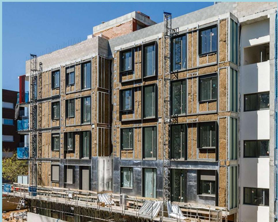
Aislamiento de una fachada mediante lana de roca. Fuente: ULMA ARCHITECTURAL SOLUTIONS
