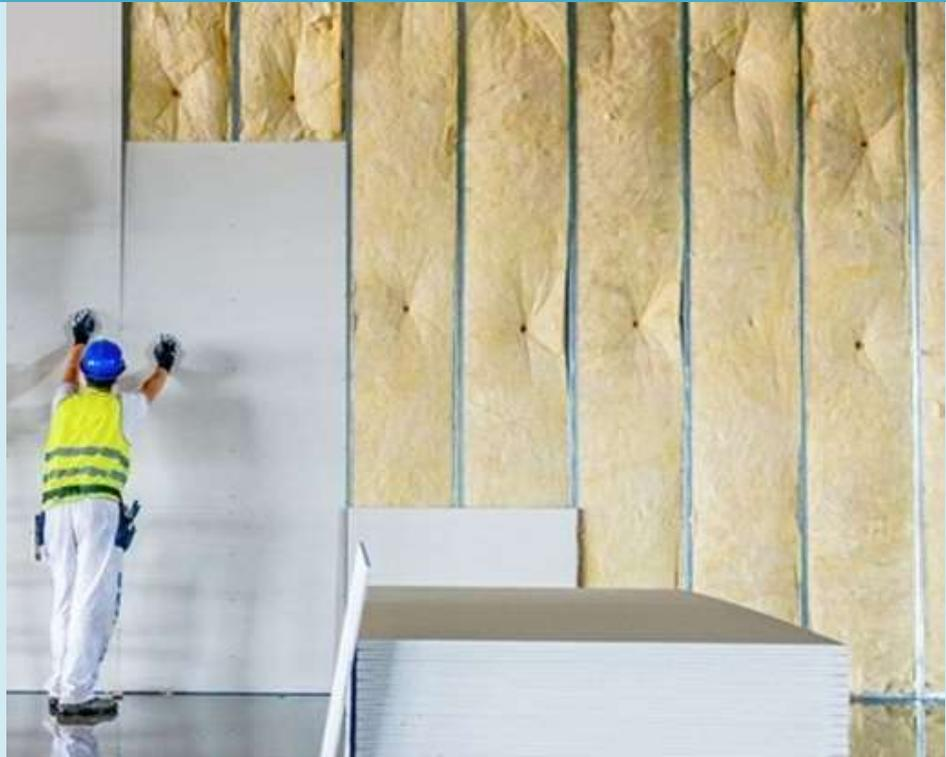
Aislamiento de un muro interior mediante lana de vidrio. Fuente: <https://www.plack.com.br>
