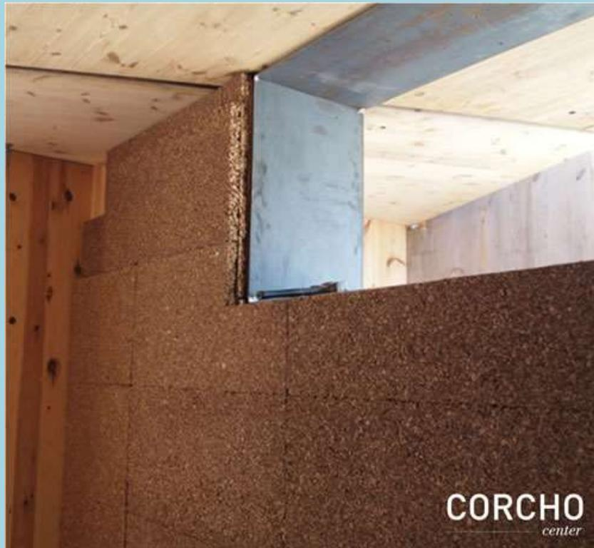
**Aislamiento de una pared mediante tableros de corcho negro expandido. Fuente: CORCHO Center**
