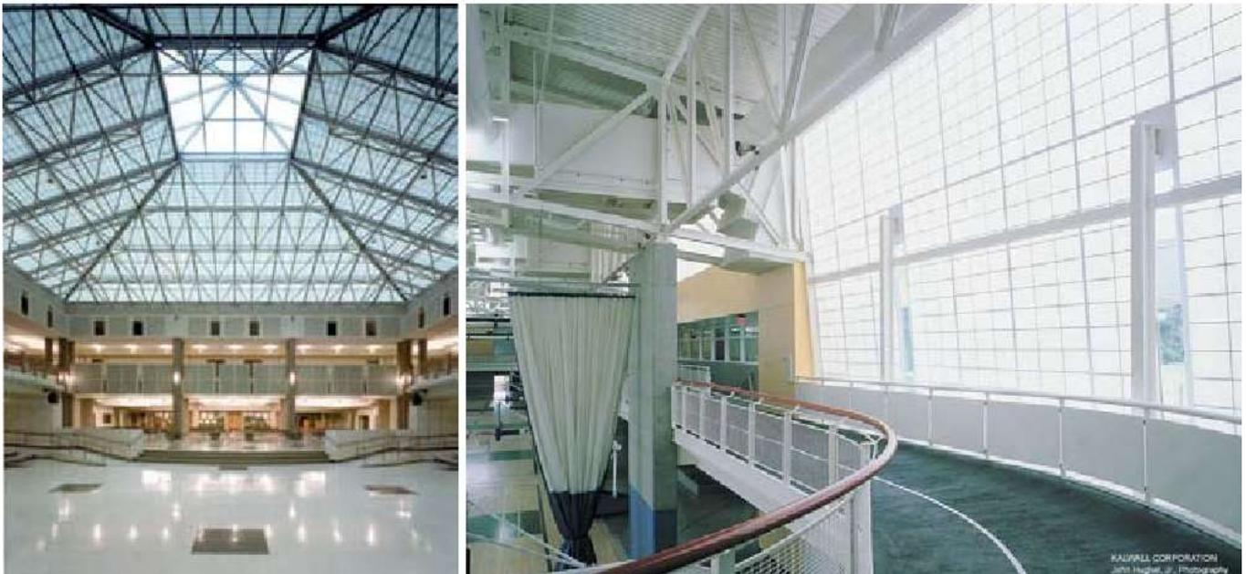
Figura 7. Dos ejemplos de aislamiento mediante aerogel traslúcido como una solución de elevado aislamiento para luz diurna. FUENTE: Baetens, Jelle y Gustavsen (2011)
