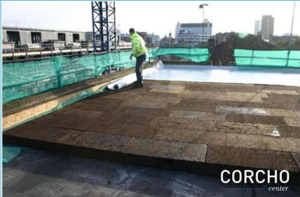
**Aislamiento de una cubierta mediante tableros de corcho negro expandido. Fuente: CORCHO Center**
