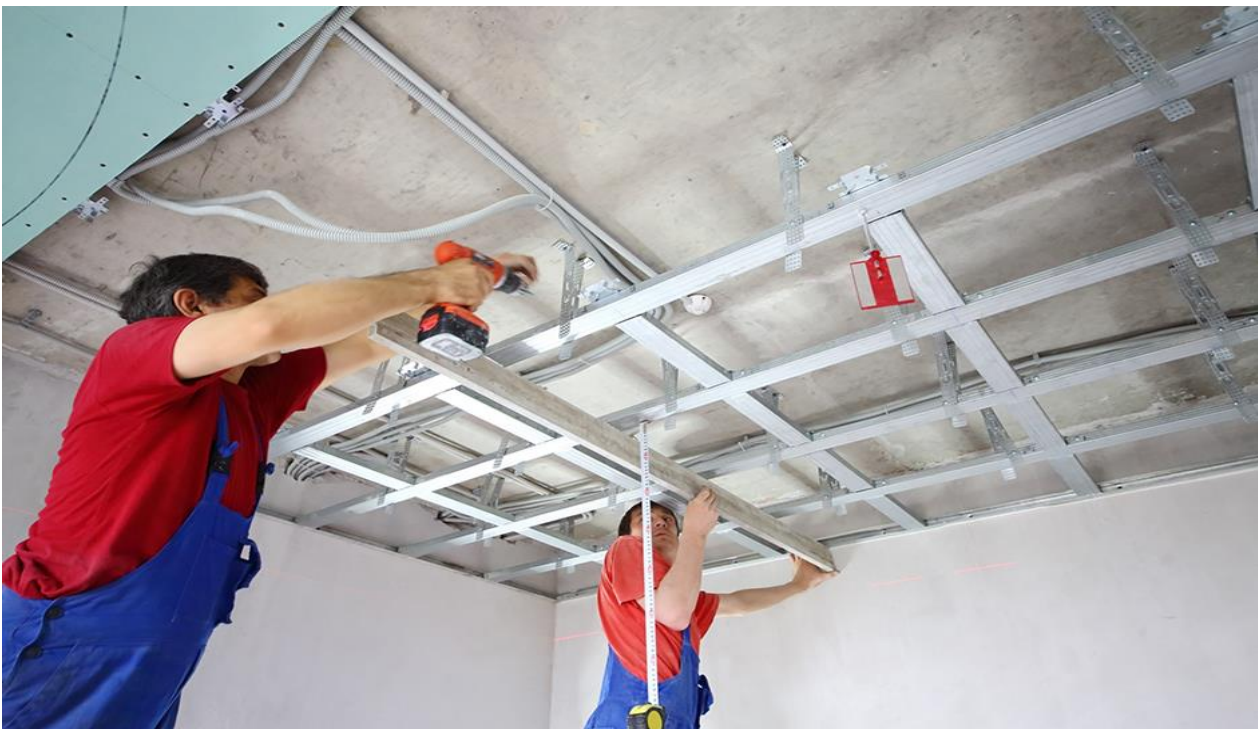
Imagen 24. Montaje de los perfiles metálicos que luego sostendrán las placas de yeso laminado del falso techo. Fuente:
