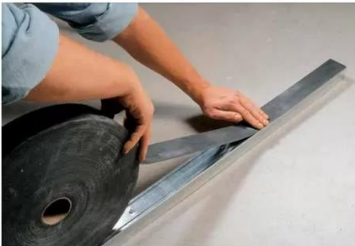
Imagen 18. Colocación de una banda acústica en un perfil metálico. Fuente: Ferrocenter
