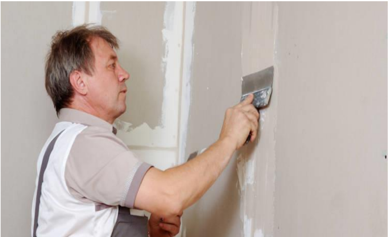
Imagen 22. Aplicación de la pasta para juntas entre las placas de yeso laminado. Fuente: Celia Arroyo
