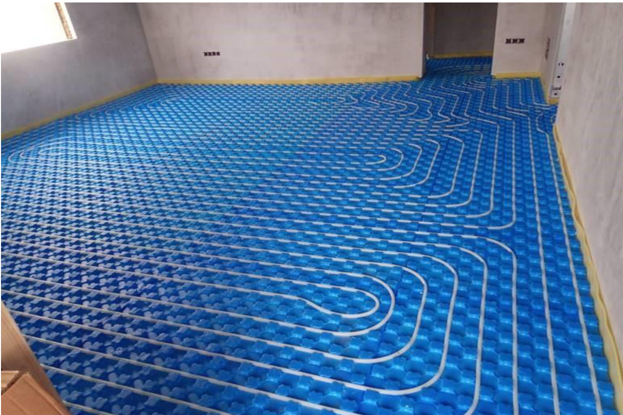
Imagen 14. Ejemplo de suelo radiante. Fuente: STHExpert
