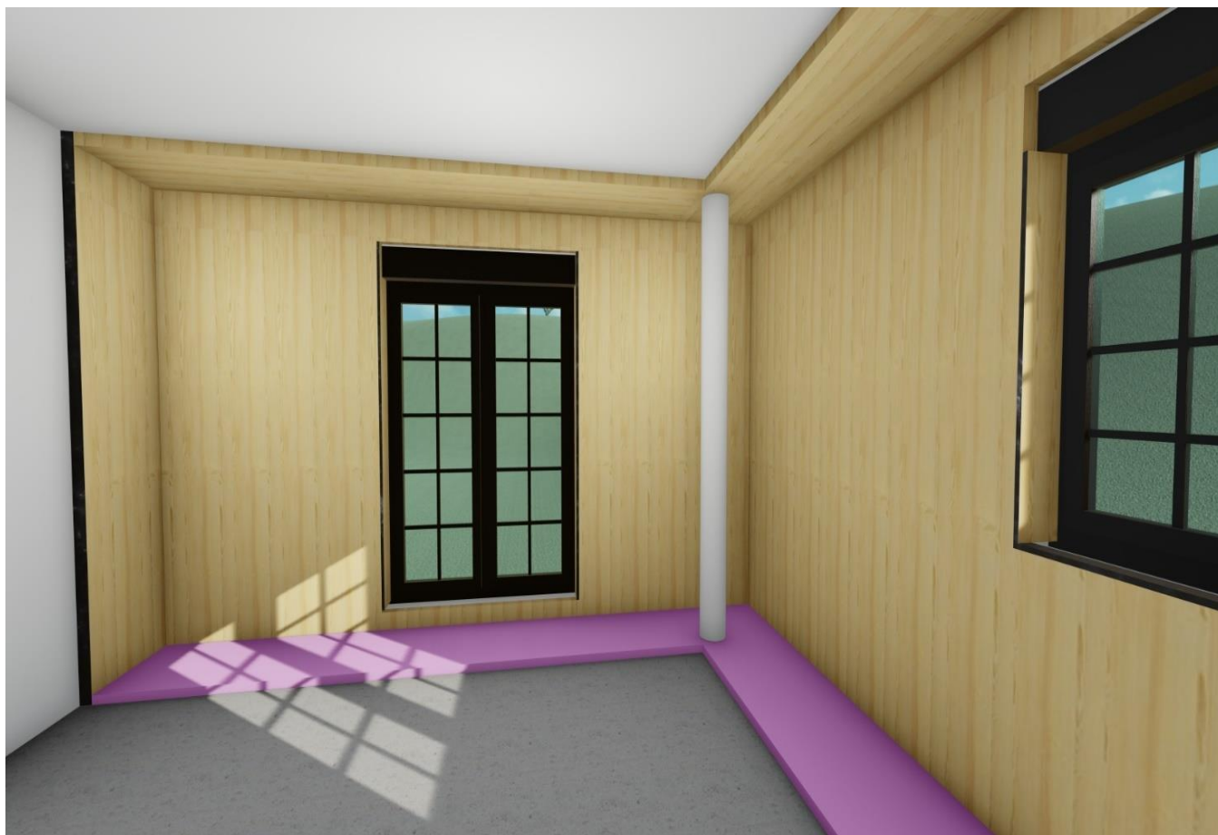
Imagen 7. Tableros IDSiate instalados sobre los muros y el techo mediante adhesivo.
