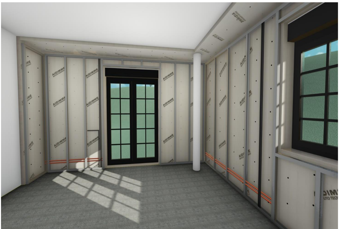
Imagen 21. Conducciones y cables (en rojo y en negro) ya instalados.
