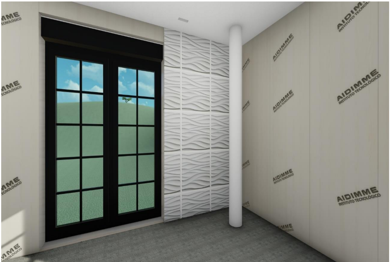
Imagen 12. Tableros IDSiate con barrera de vapor cubierto en parte por un panel decorativo (a la derecha de la puerta y hasta la columna).
