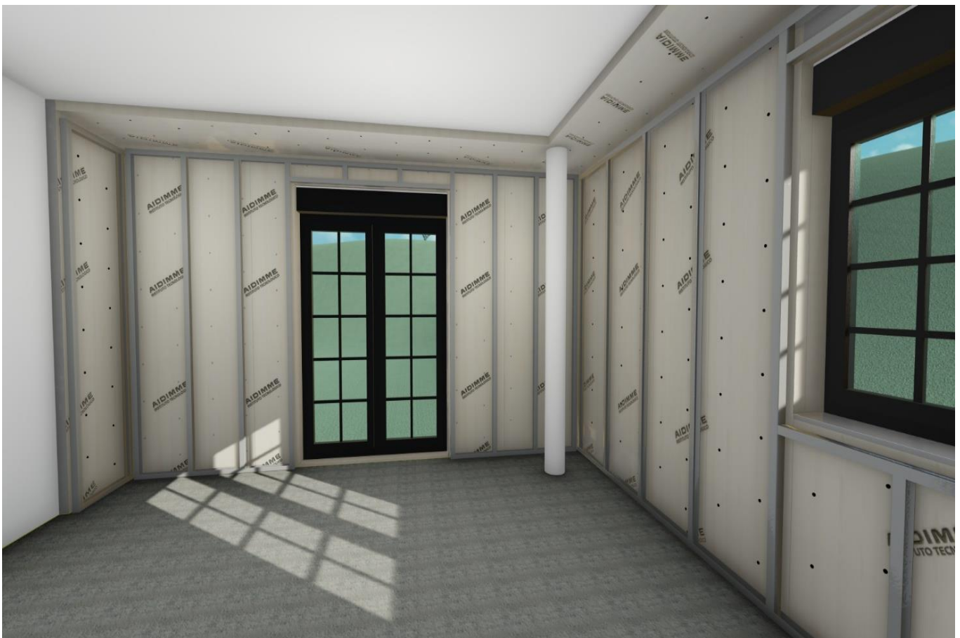
Imagen 20. Perfiles metálicos fijados a los muros, sobre los tableros IDSIATE con barrera de vapor encima.
