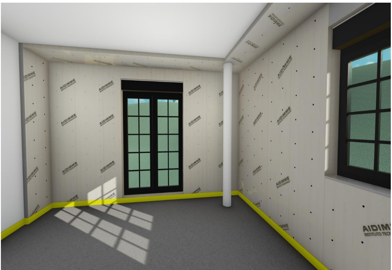
Imagen 13. Suelo relleno y nivelado.
