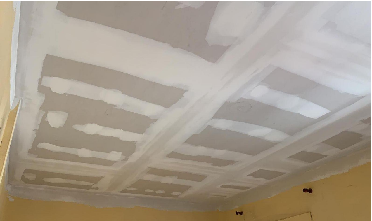
Imagen 26. Placas de yeso laminado de un falso techo después de rellenar las juntas. Fuente: Instalaciones Óscar Magro
