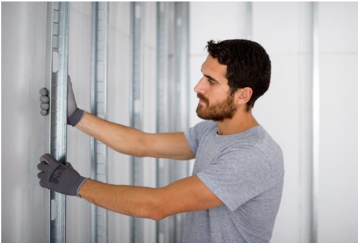
Imagen 19. Instalación de los montantes metálicos. Fuente: Leroy Merlín
