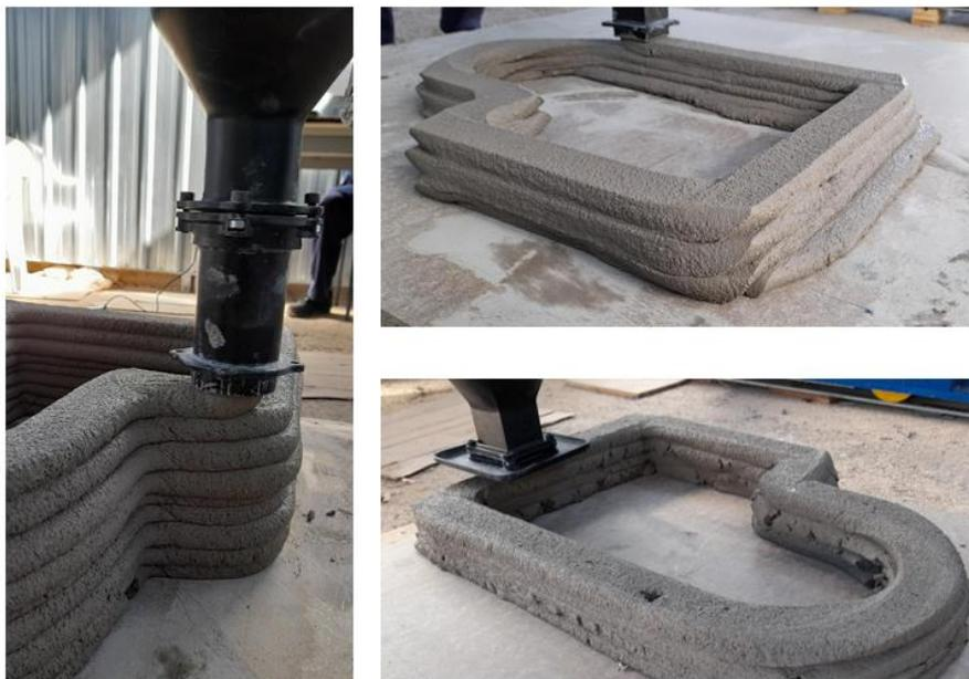
**Figura 4:** Pruebas de distintas boquillas de impresión para mejora de acabados.
