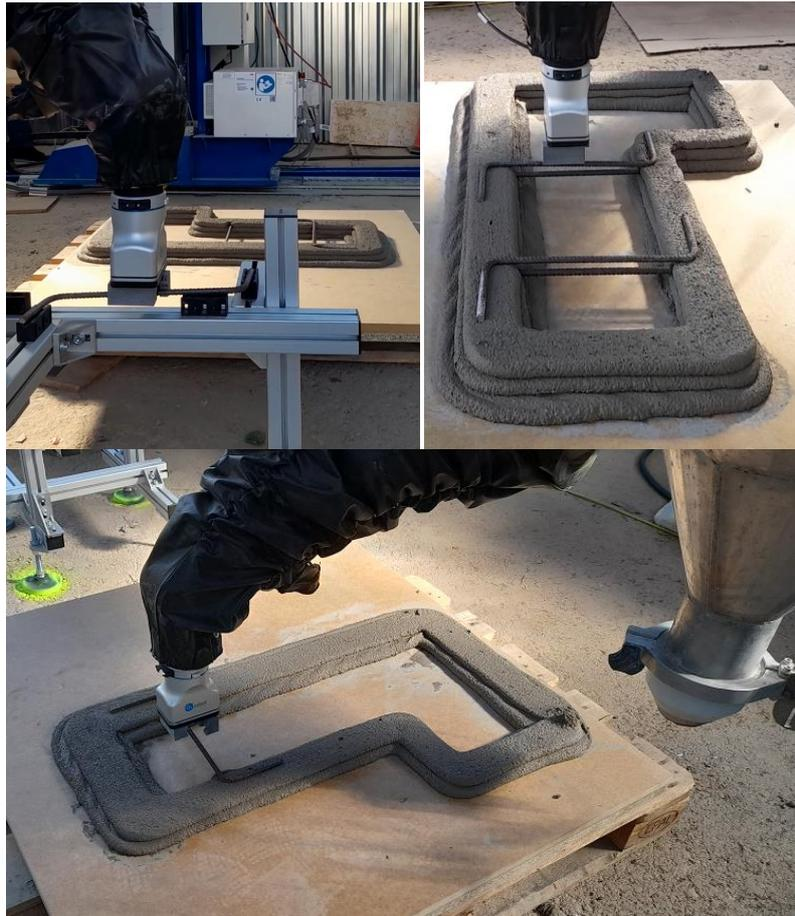
**Figura 3:** Pruebas de trabajo combinado impresión/colocación de armaduras.
