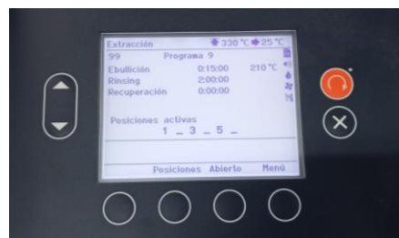
Figura 9. Panel de control con las variables de proceso programadas.
