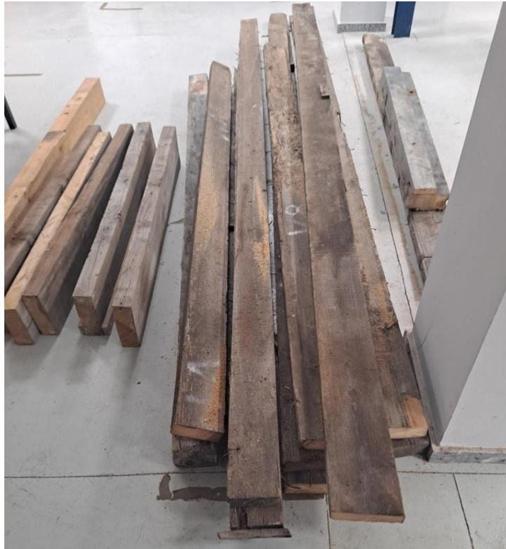
**Imagen 6. Ejemplo de viguetas obtenidas para el proyecto procedentes de edificios de Godella, Rocafort y Xàtiva en proceso de rehabilitación, saneadas todas ellas antes de su acondicionamiento.**
