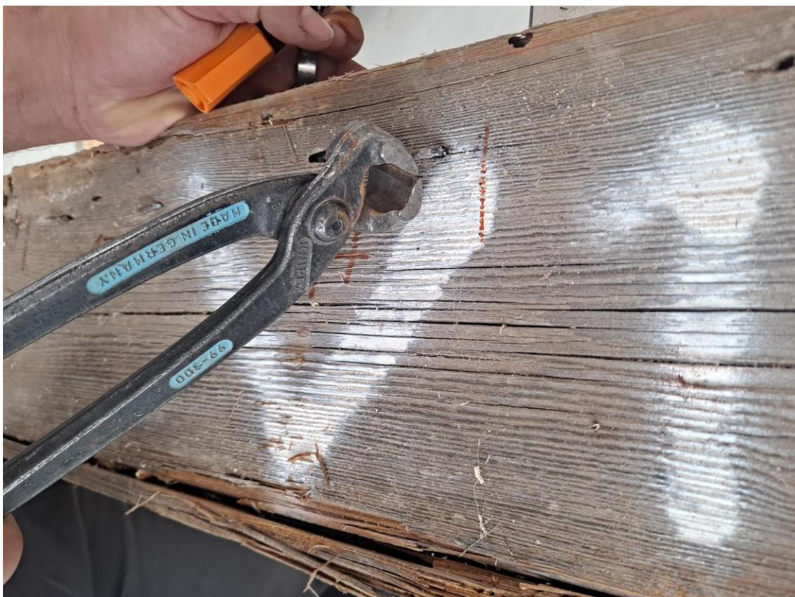
Imagen 18. Eliminación de clavos en una vigueta durante el proceso de saneamiento.
