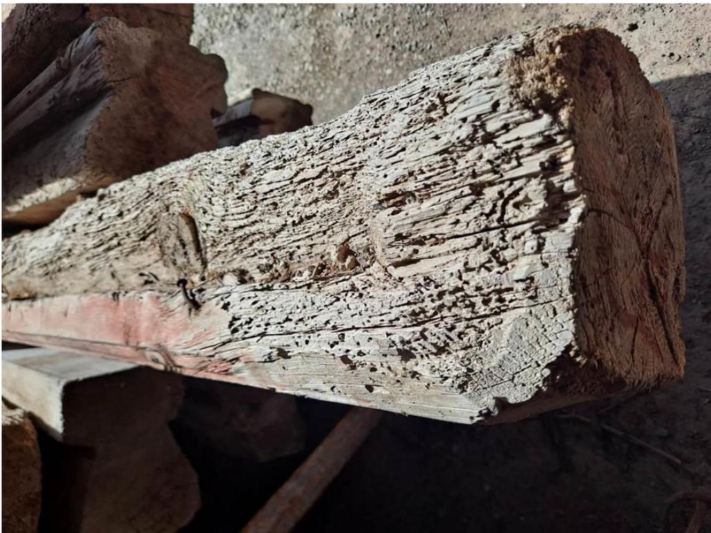
**Imagen 5. Degradación en una de las viguetas acopiadas, debida a carcoma y hongos de pudrición. Esta degradación fue saneada antes de acondicionar la vigueta.**
