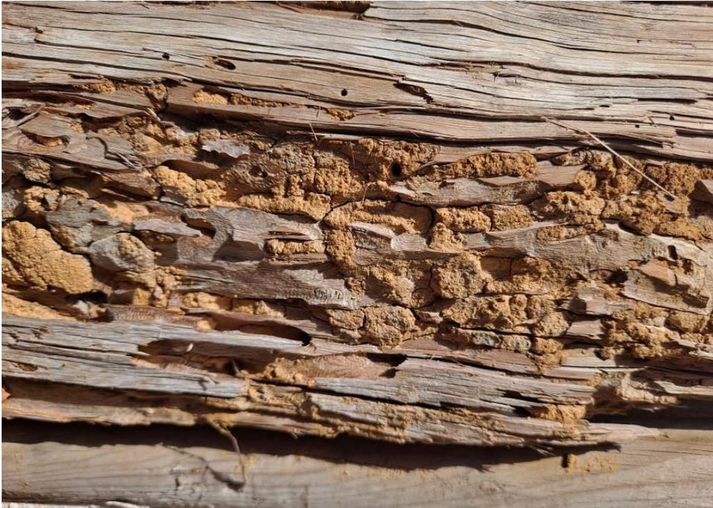
**Imagen 4. Degradación en una de las viguetas acopiadas, debida a carcoma y hongos de pudrición. Esta degradación fue saneada antes de acondicionar la vigueta.**
