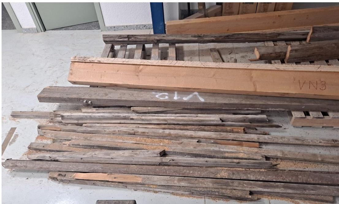
**Imagen 7. Ejemplo de viguetas obtenidas para el proyecto procedentes de edificios de Paterna en proceso de rehabilitación, saneadas todas ellas antes de su acondicionamiento.**
