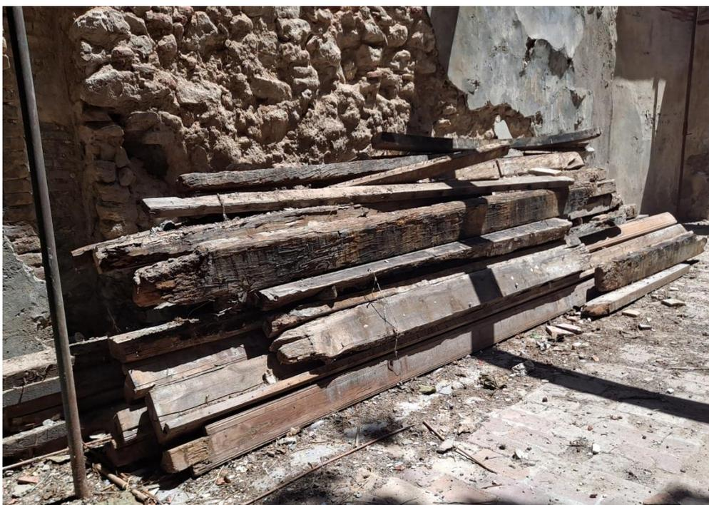
**Imagen 3. Ejemplo de viguetas obtenidas para el proyecto procedentes de un edificio de El Cabañal en proceso de rehabilitación, antes de su recogida por AIDIMME.**
