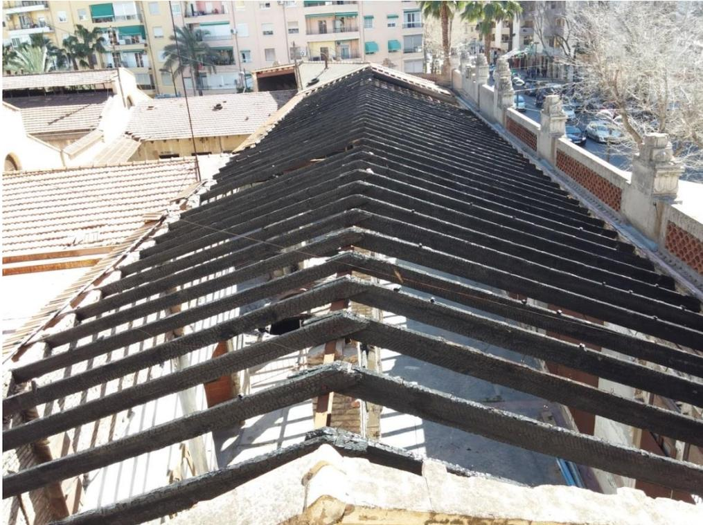
Imagen 2. Cubierta de madera de un edificio histórico valenciano tras un fuerte incendio.
